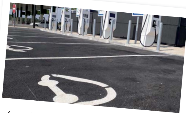
Les réseaux de recharge privés tiennent pour le moment le haut du pavé.
